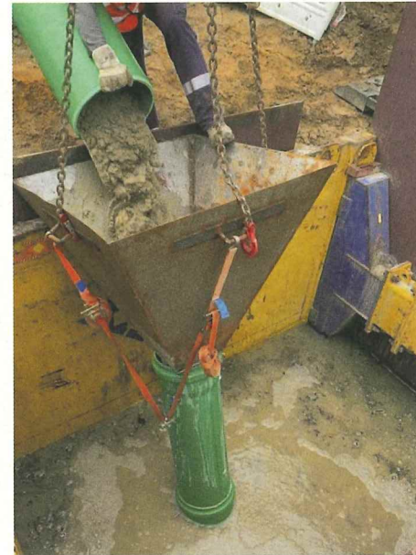
Einfüllung Flüssigboden im Kontraktorverfahren für den Einbau unter Wasser
