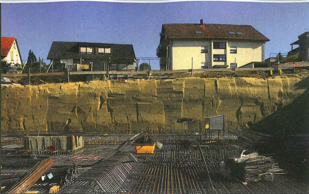
Träger-RSS-Flüssigboden-Wand | Fotos: Flüssigboden Engineering GmbH
