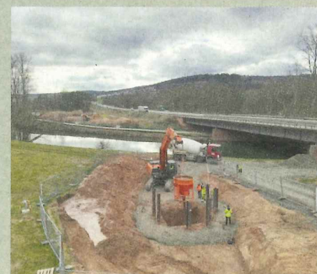
Damit sich der Flüssigboden beim Einbringen in die tiefe Grube nicht durch zu hohen Energieeintrag entmischt, wurde er mit Kübeln und somit geringerer Fallhöhe eingebracht.
