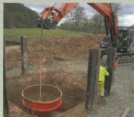
Damit sich der Flüssigboden beim Einbringen in die tiefe Grube nicht durch zu hohen Energieeintrag entmischt, wurde er mit Kübeln und somit geringerer Fallhöhe eingebracht.
