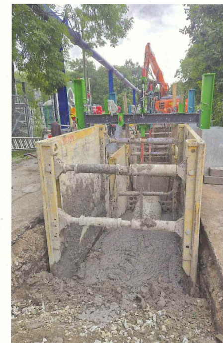
Flüssigboden umschließt und bettet das Kanalrohr nahtlos – ein wichtiger Aspekt bei der Gütesicherung. | Foto: Witing – Heinrich Lauber
