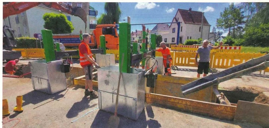
Fünf Verbauboxen und drei Rohrverlegethilfen im Einsatz. | Foto: Hauser Service
