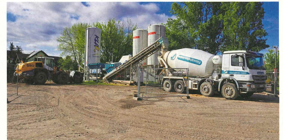
Der Flüssigboden wurde in unmittelbarer Nähe zur Baustelle in einer mobilen Anlage hergestellt. | Foto: Witing – Heinrich Lauber
