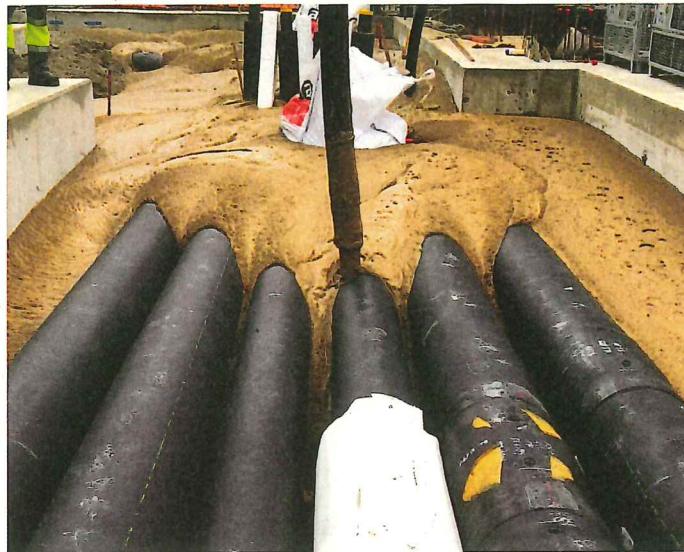
Beim Einbau des Flüssigbodens auf der Baustelle Flughafen München waren besonders logistische Herausforderungen zu meistern. | Foto: Bernhard Rott GmbH & Co. KG
