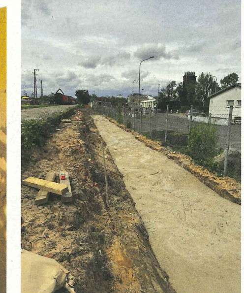
Der Flüssigboden nach seiner Einfüllung in den Rohrleitungsgraben. Der Verbau wird unmittelbar danach gezogen, damit sich die Verbauspur ebenfalls mit Flüssigboden verfüllt. | Fotos: Südwestdeutsche Rohrleitungsbau GmbH
