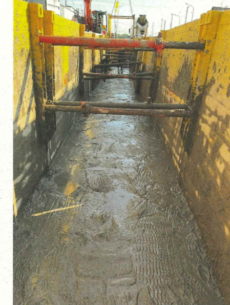
Der Flüssigboden nach seiner Einfüllung in den Rohrleitungsgraben. Der Verbau wird unmittelbar danach gezogen, damit sich die Verbauspur ebenfalls mit Flüssigboden verfüllt. | Fotos: Südwestdeutsche Rohrleitungsbau GmbH
