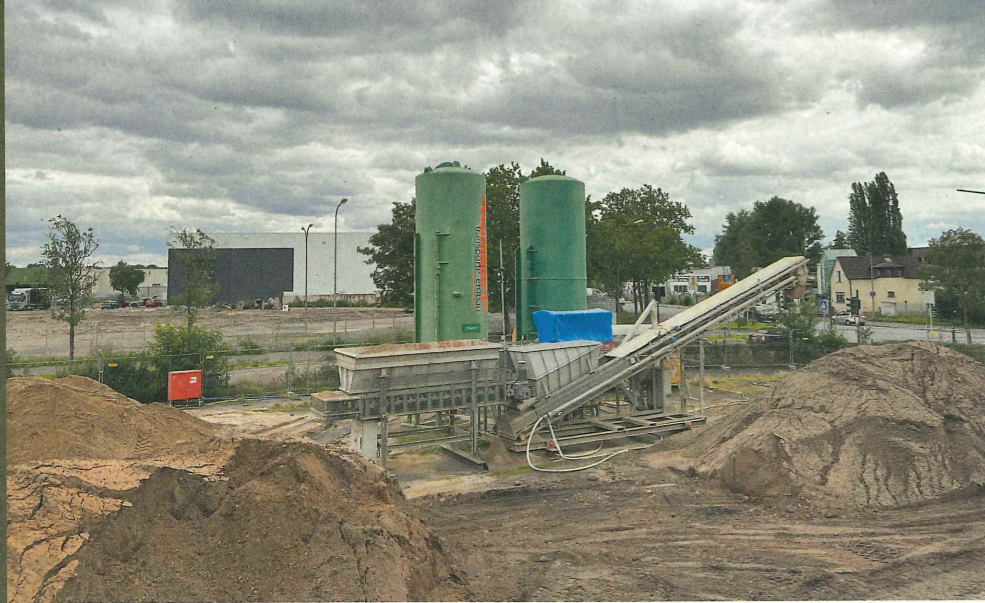
Die „Flüssigbodenfabrik“ in Hanau an der Birkenhainer Straße: Hier wird der Bauaushub zwischengelagert, separiert und in einer mobilen Kompaktanlage gemäß der vorgeschriebenen Rezeptur in Flüssigboden nach RAL-GZ 507 umgewandelt.
